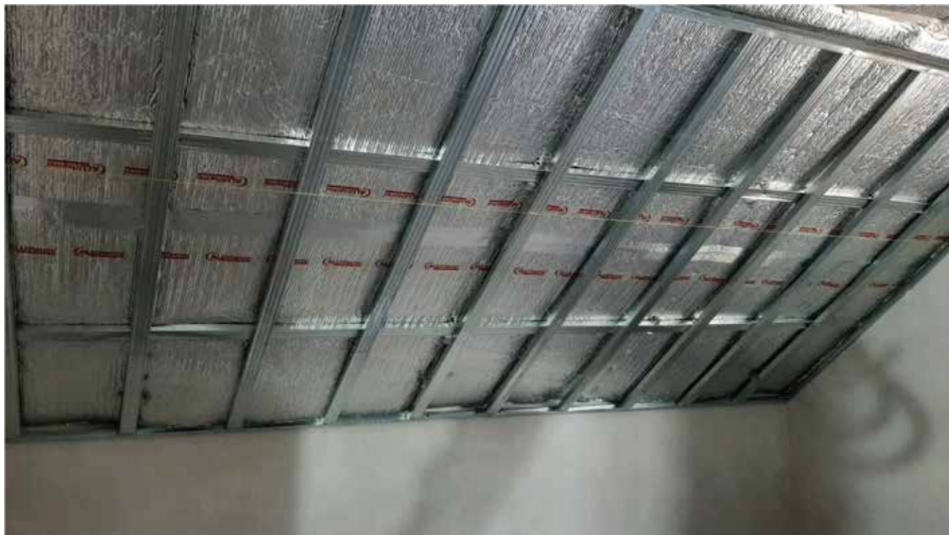
Przykładowa realizacja w systemie podkrokwiovym
