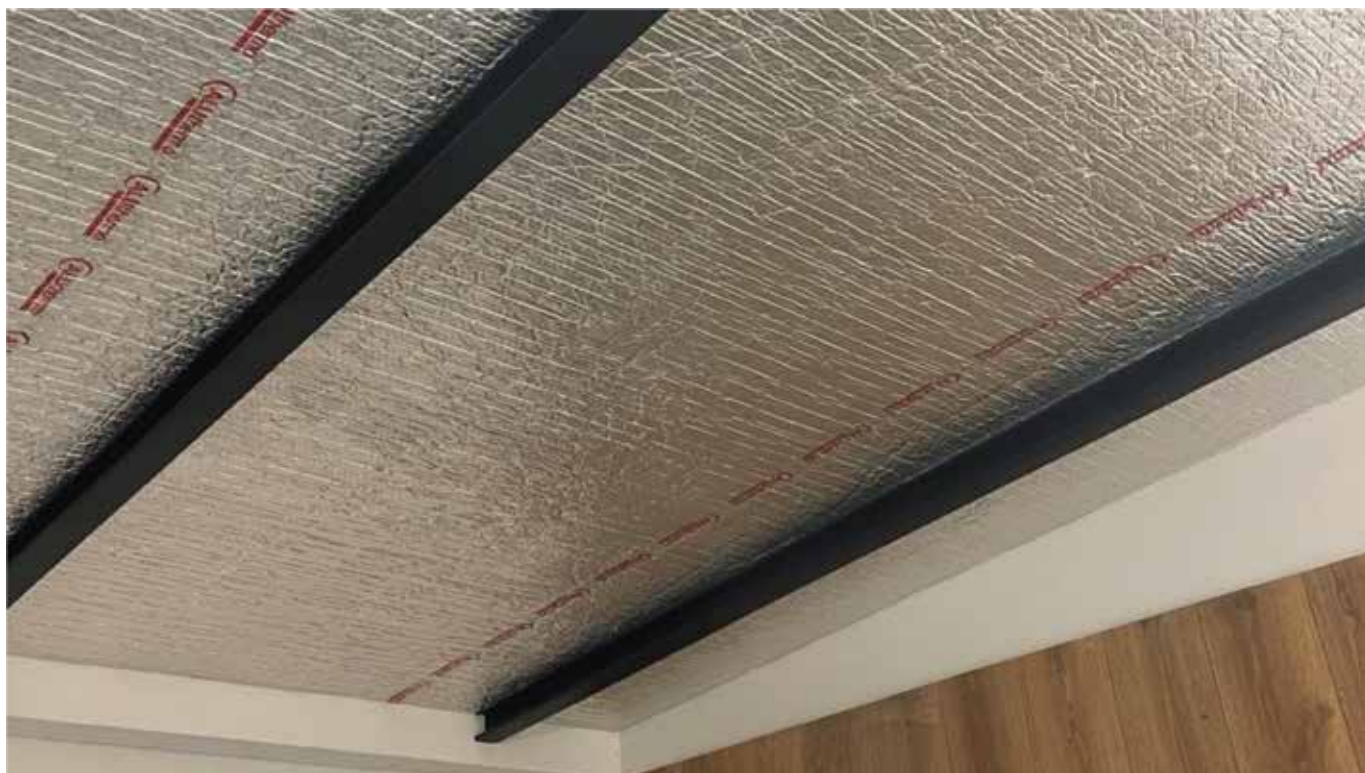
Przykładowa realizacja w systemie międzykrokwowym
